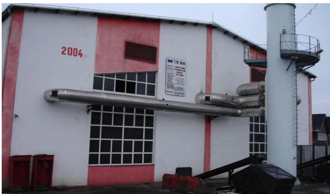
Fig. 2.1 Centrala termică pe deșeuri lemnoase
