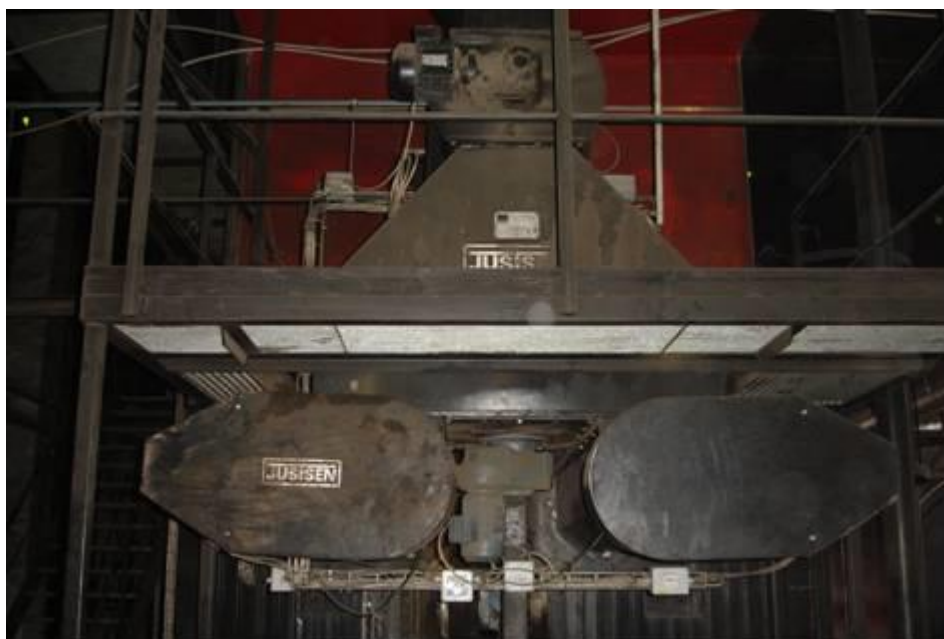
Figura 2.2. Prezentare de ansamblu a unuia dintre cazanele ce folosește deșeurile lemnoase
