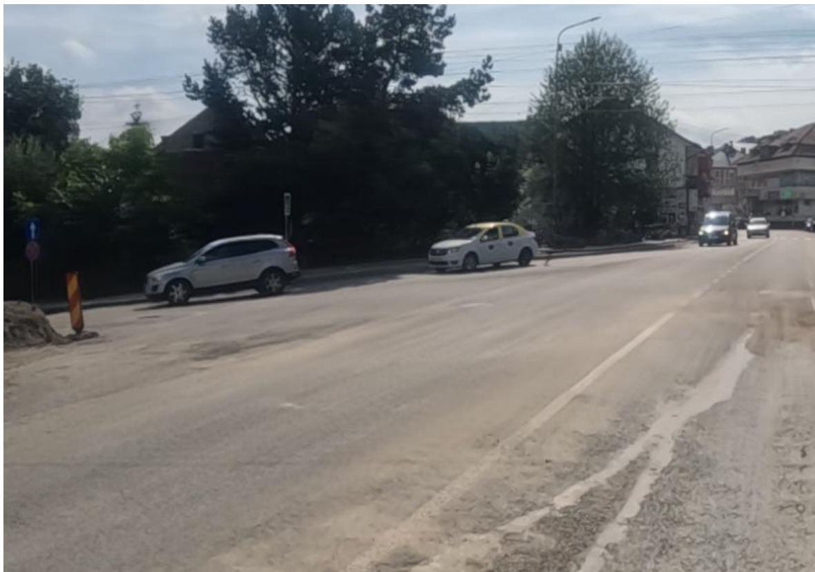
Fig. 26 Intersecția Str. 22 Decembrie cu str. Unirii
