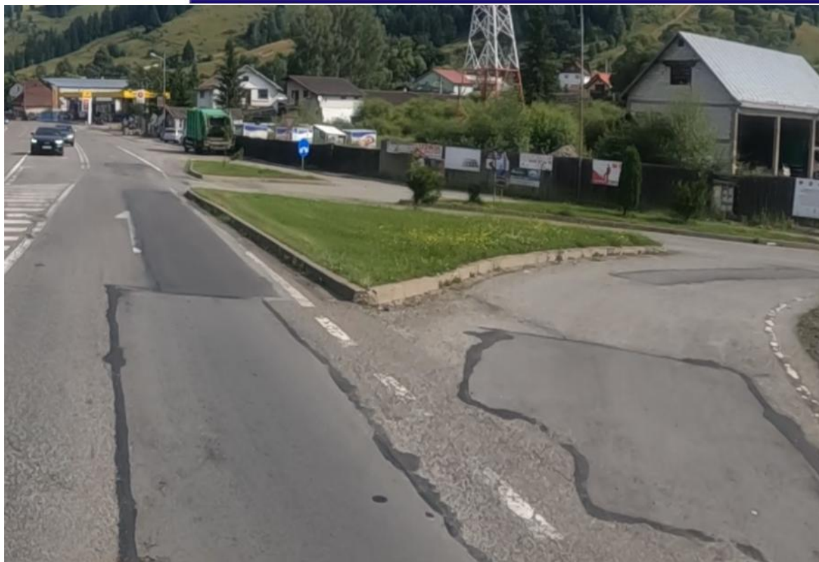
Fig. 30 Intersecția Str. Argeștru cu str. Bistriței
